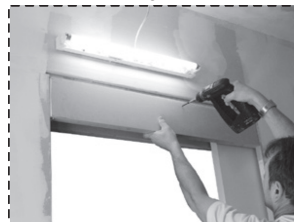
18 Sturzverkleidung montieren
