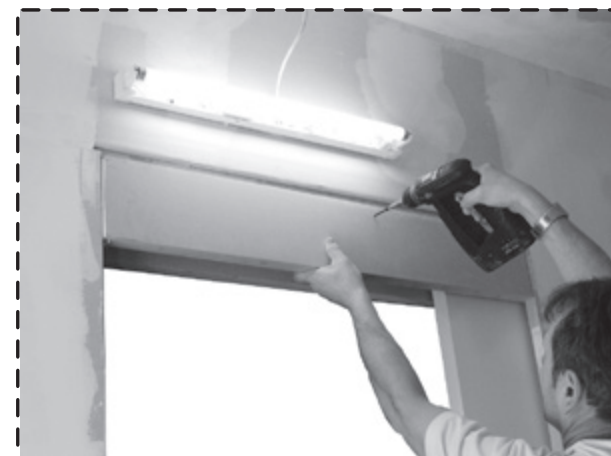
18 Sturzverkleidung montieren
