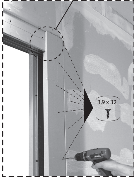
14 Verschrauben (ECLISSE Schrauben 3,9 x 32)
