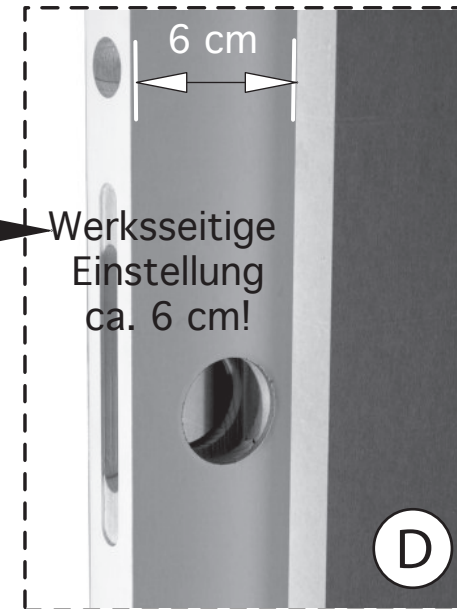
D) Wenn Sie die Laufschiene nicht ausbauen und die werkseitige Einstellung belassen, steht das Türblatt 6 cm in die fertige STL ein.
