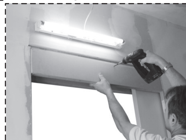
17 Sturzverkleidung montieren
