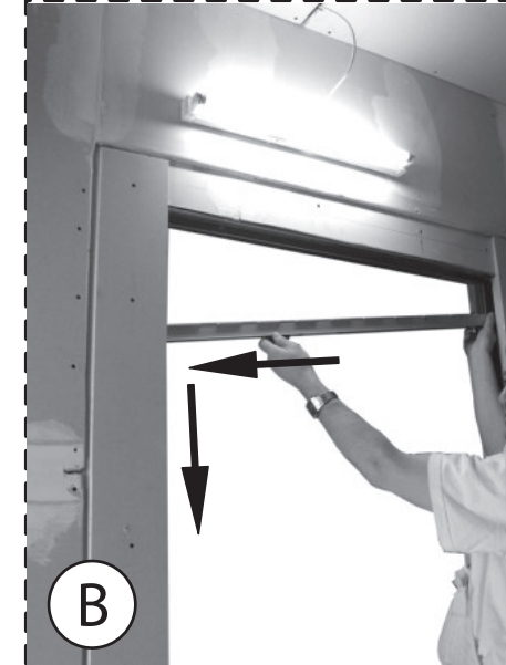
B) ...und ziehen Sie die Laufschiene nach vorne. Die Laufschiene fällt im Schubkasten aus Ihrer Verzahnung.
